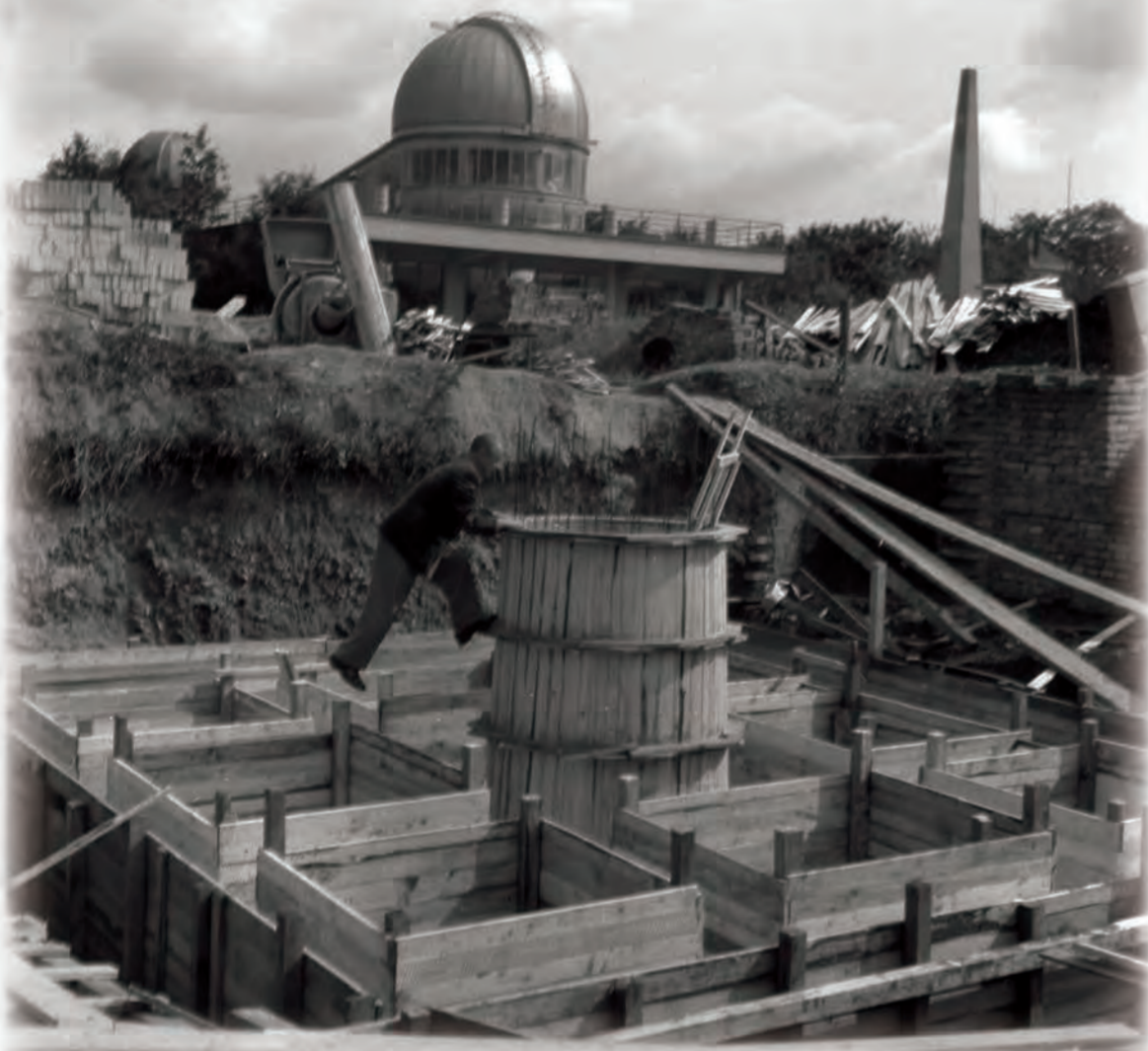
Josef Doleček kontroluje základy stavby nové observatoře.
