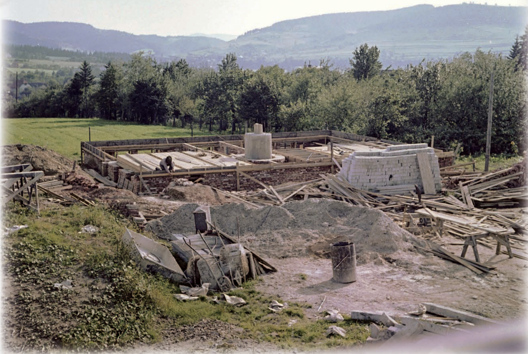
Základy budovy odborného pracoviště.
