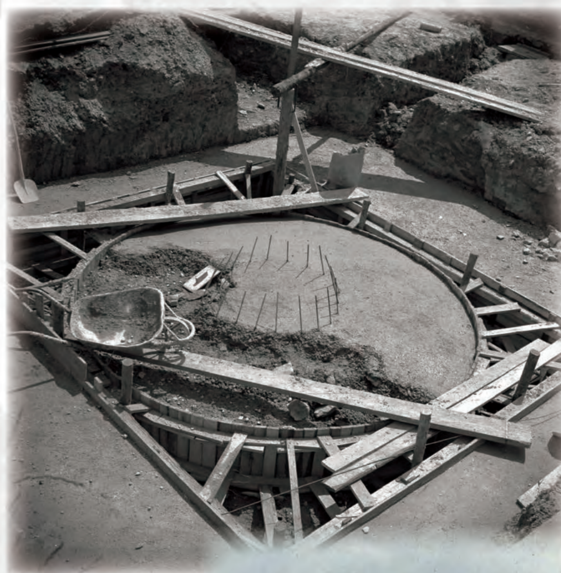
Založení sloupu kopule jižní budovy. Jeho základy jsou odděleny od základů budovy.
