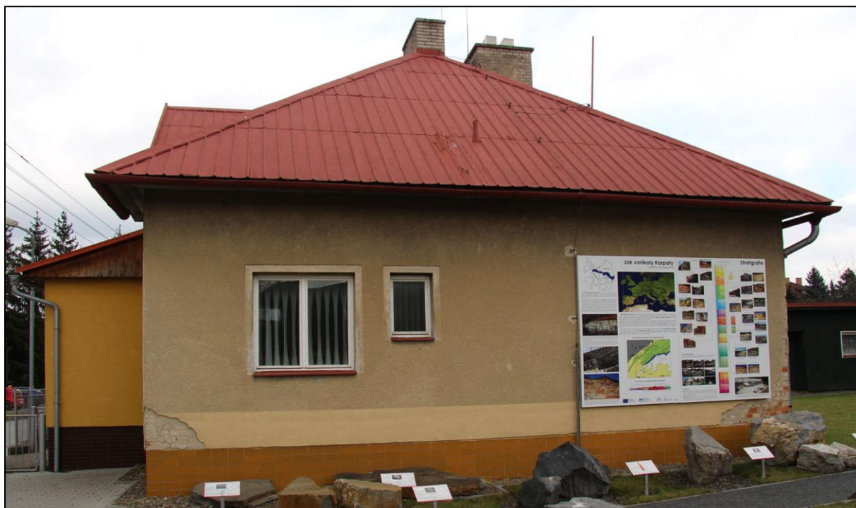
Vzhled objektu před realizací akce
