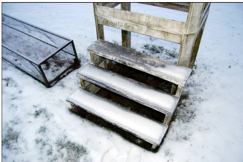
Obrázek č. 5 - Detail stávajících schůdků, které budou nahrazeny novými s nášlapy z pororoštu.
