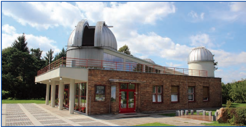
Hlavní budova hvězdárny po rekonstrukci v roce 2013.
