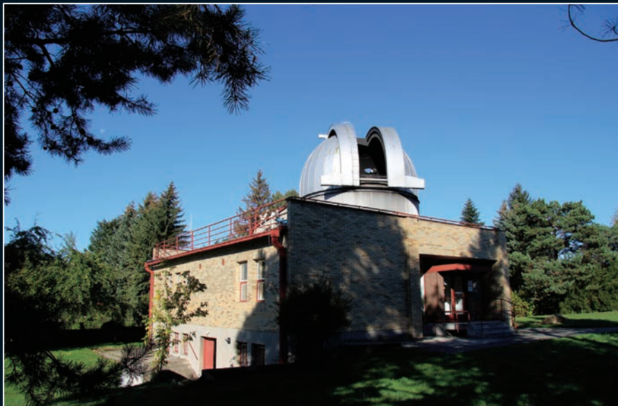
Budova odborného pracovišťa na sklonku léta 2015.
