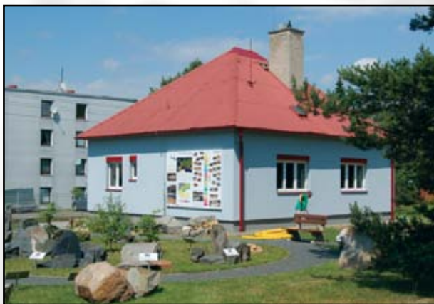
Provozně-technický objekt těsně před dokončením
