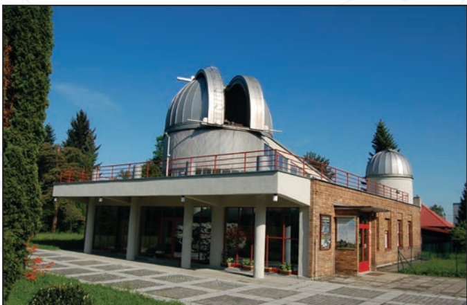
Hlavní budova Hvězdárny Valašské Meziříčí prošla v roce 2012 první etapou bavarijní rekonstrukce.
