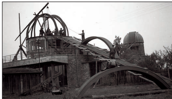
Instalace komponent hlavní kopule v roce 1953. Na snímku je zachycena i nakloněná rovina, která sloužila k dopravě částí kopule do místa uložení.
