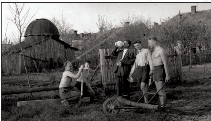
Rok 1947: úprava pozemku před zabíjením stavby. Muž uprostřed se dřevěným je Antonín Ballner.
