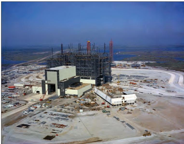
Takto vše začalo: stavba hangáru VAB.
