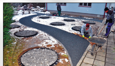
Dokončování stavebních prací nové části venkovní geologické expozice, která je věnovaná jesenickému krystaliniku.
